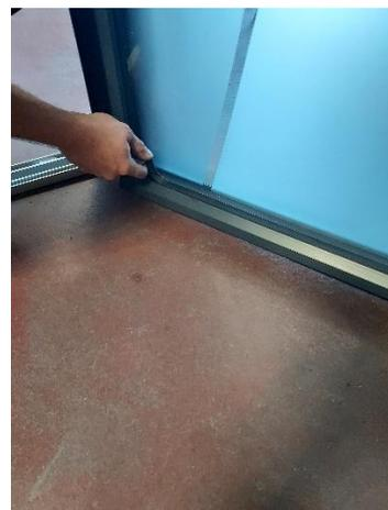
**2 Retirer les vis de serrage des parcloles en haut de l'ouvrant. (Elles sont vissées que sur les traverses de parcloles en coupe 45°)**
